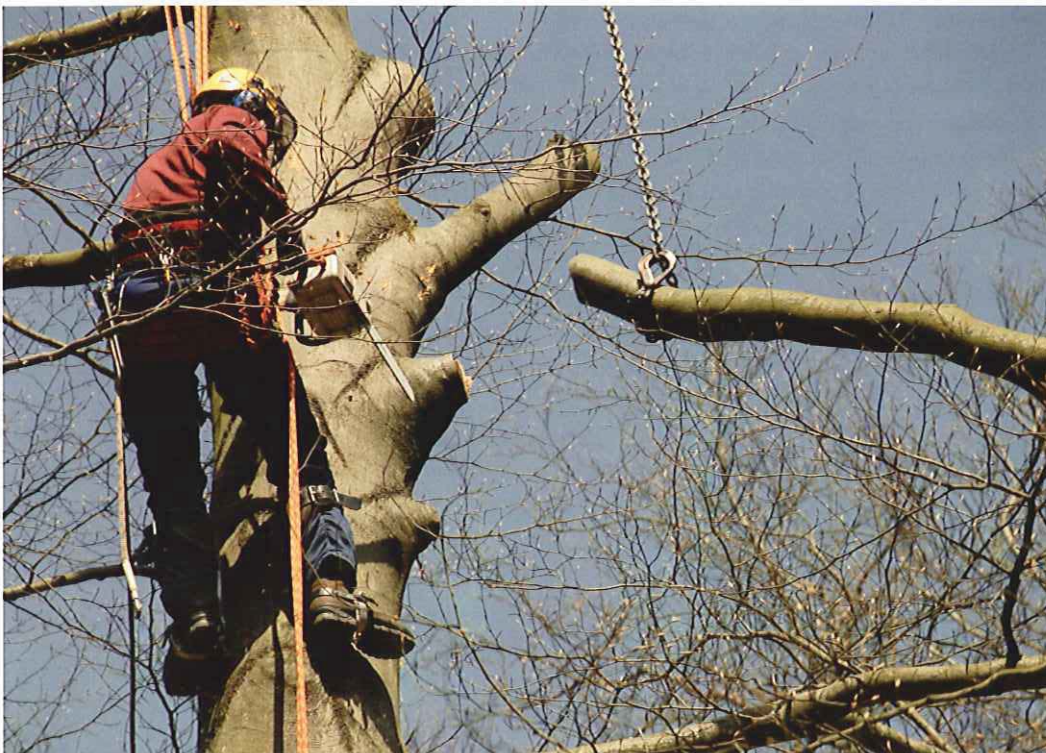
Werken met klimgordel en klimlijnen vereist een opleiding en een certificaat.
